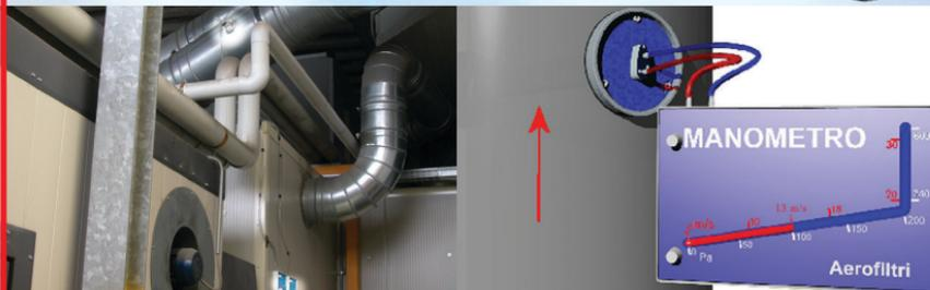
La sonda K-Flow è un tubo di Pitot multipunto dotato di accorgimenti esclusivi:
